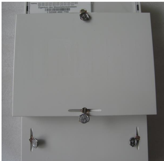
Figure 7 Verwenderversiegelung
